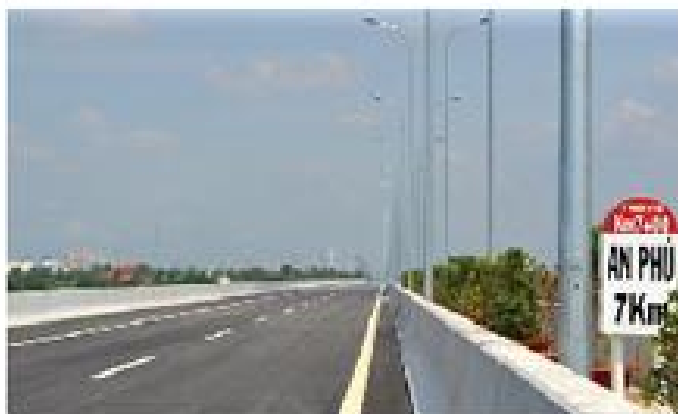
Đường cao tốc đoạn đầu tuyến trên địa phận TP.HCM đã được thi công xong
